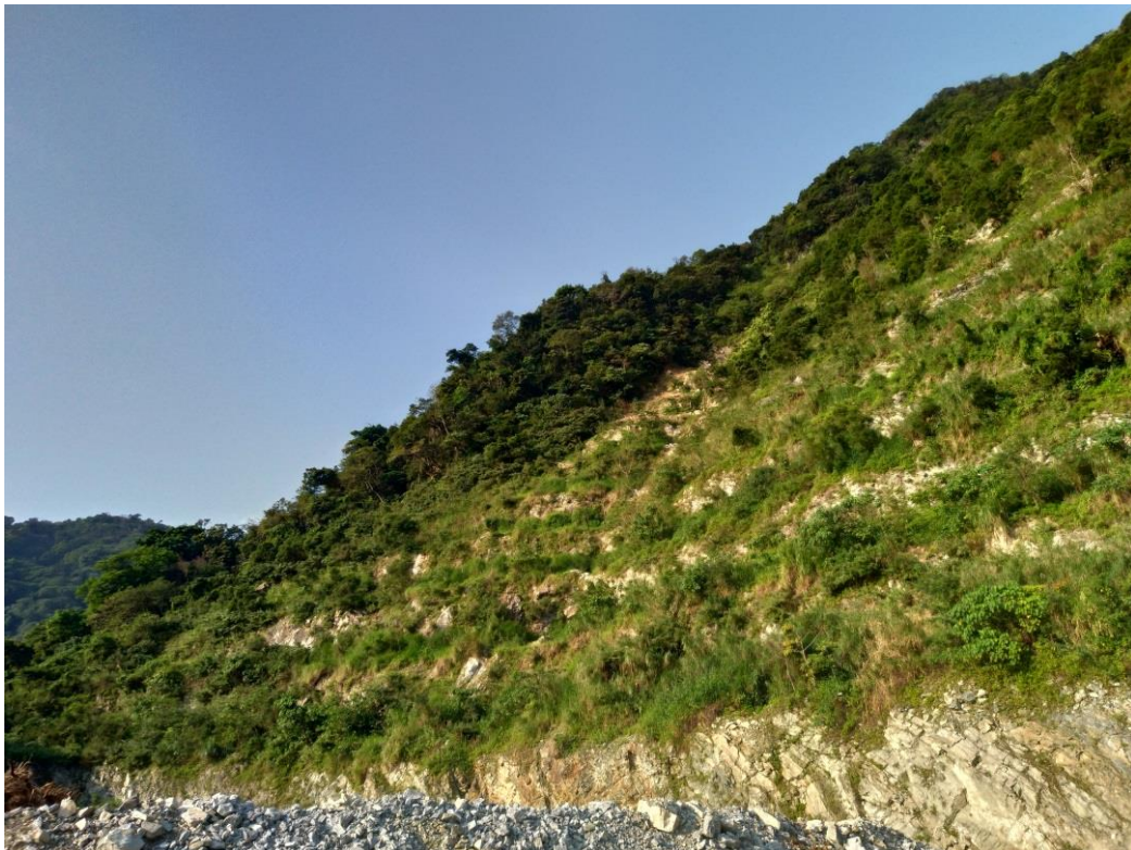
圖四、南側邊坡完整
