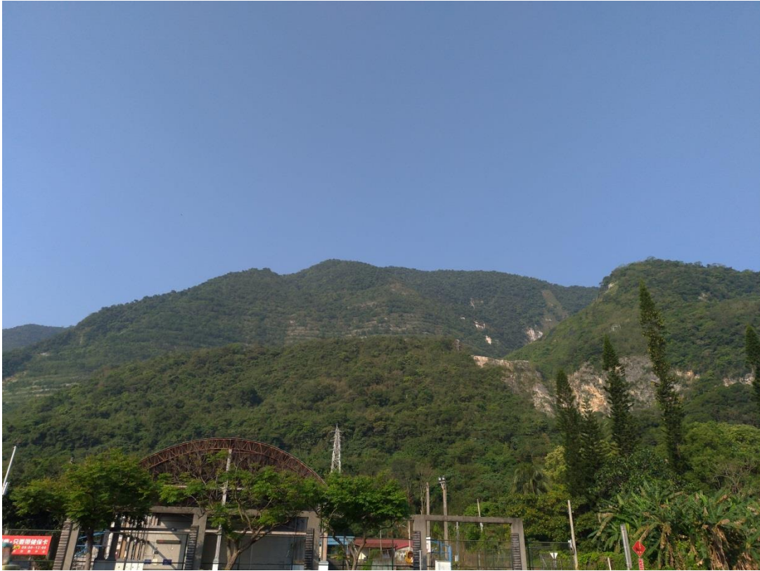
圖七、礦場外近富世村邊坡完整，未發生崩坍及落石
