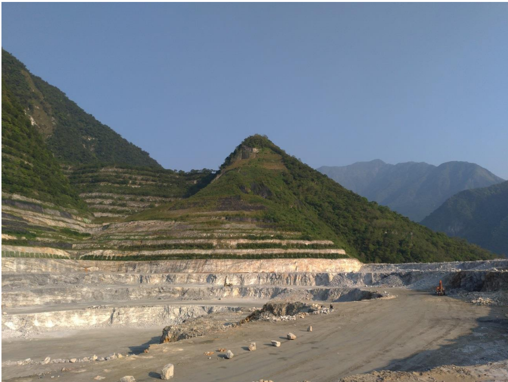
圖二、北側邊坡目視完整，植被保持良好，無發生崩坍及落石
