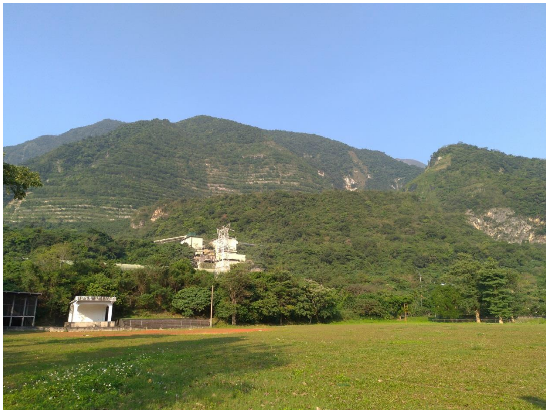
圖六、礦場外近富世村邊坡完整，未發生崩坍及落石
