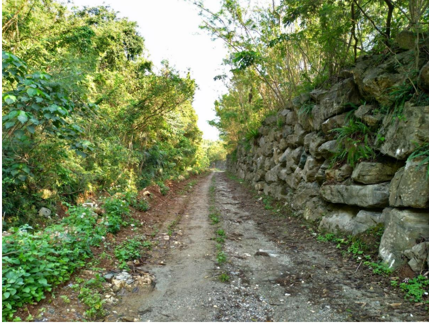
圖三、沈砂池聯外道路、攔石牆、排水溝未發生崩坍及落石
